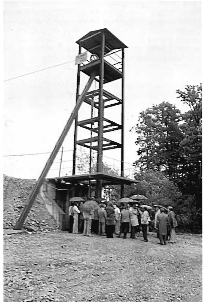
Der fertige Schacht bei der Einweihung. Der Füllort in Höhe des Dammes wurde später noch umkleidet.
