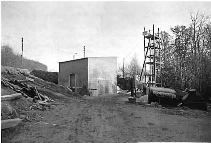
Bauarbeiten am Fahr- und Förderschacht. Standort beim Mahlwerk. Links der Damm mit den Fördergleisen, ganz im Hintergrund (nicht erkennbar) hinter dem unfertigen Schachtgerüst das Mundloch des Bremsbergs. Im Vordergrund das Fördermaschinenhaus.
