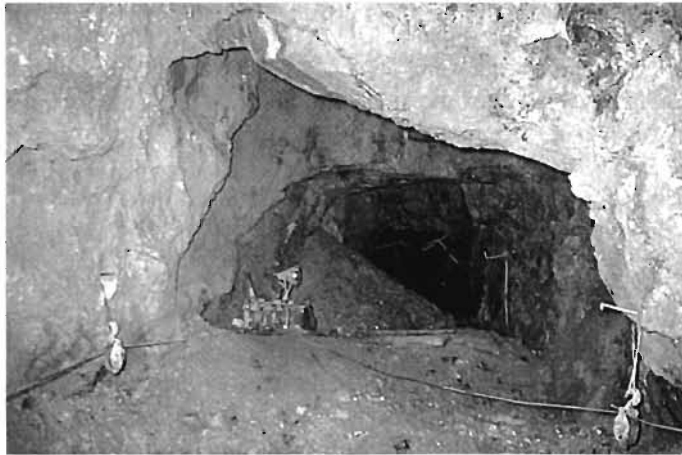
Firstenstoßbau zwischen 4. und 3. Sohle. Im Mittelgrund der Haspelantrieb, im Vordergrund zu beiden Seiten Führungsrollen und Haspel.
