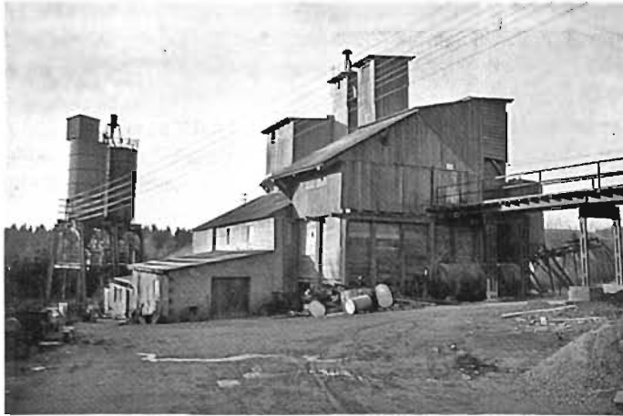
Tagesanlage, Zustand um 1970. An die Gleisbrücke anschließend das Mahlwerk, dahinter Absack- und Versandanlage. In den flächen Schuppen Magazin (vorn) und Werkstatt (hinten). Im Hintergrund die Siloanlage.
