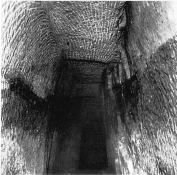
▲ Streckenquerschnitt der Periode „Saur“ (um 1750) gegen die Vortriebsrichtung gesehen. Da der Sandstein hier härter ist, sind im Vergleich zu Butzweiler die Spuren der Schlägel- und Eisenarbeit hier dichter. Stollen im Nahtenkeller, Pkt. 37–38.
