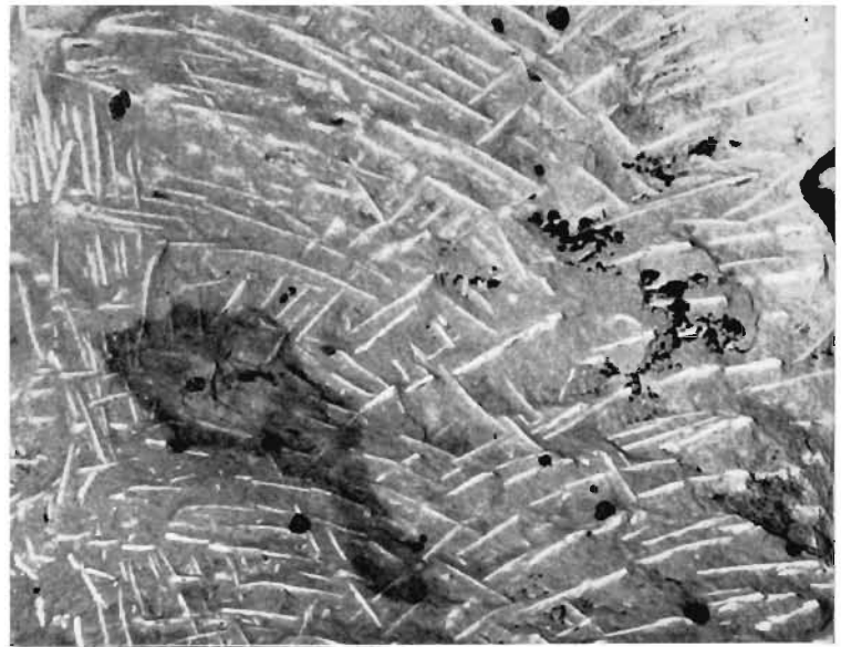
▲ Firste im unteren Emilianus-Stollen mit Werkzeugspuren in sich kreuzenden Richtungen.
