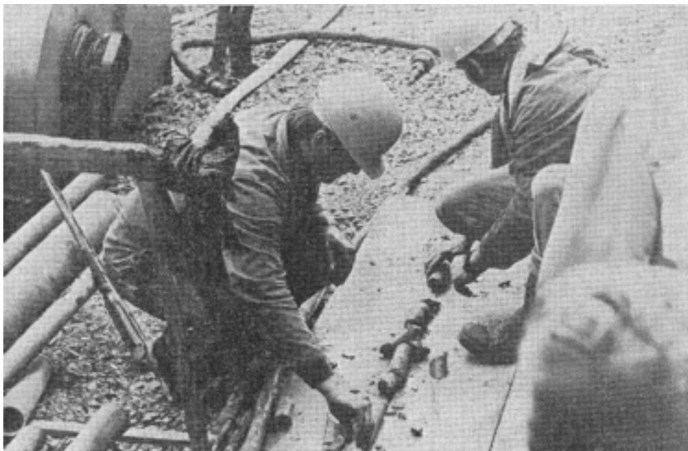
Frisch aus der Erde. Soeben haben fachkundige Arbeiter eine Gesteinsprobe aus 150 Meter Tiefe ans Tageslicht gebracht. Mittels hydraulischem Druck wird die Probe aus dem Rohr gepreßt und dann sorgsam zusammengesetzt in einen Holzkasten verpackt.
